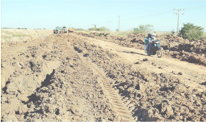
Mejoramiento Tramo San Juan Bautista - Ybyraty
