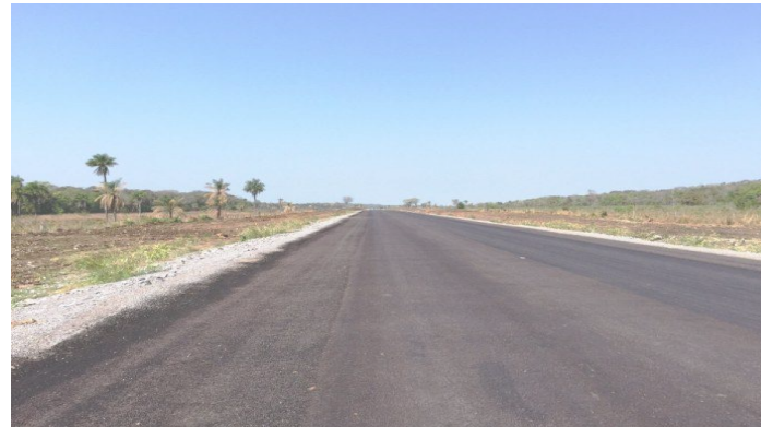
Construcción Ruta San Pedro - Belén - Concepción
