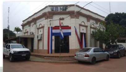
Refacción y adecuación Suc. Villa de San Pedro
